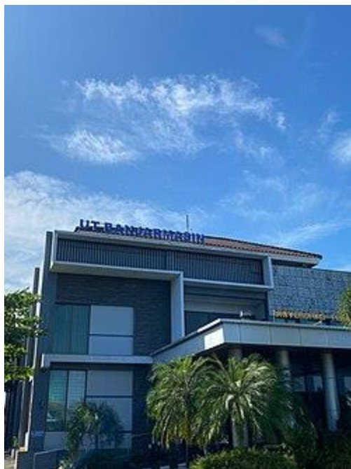
Gedung UPBJJ UT Banjarmasin
