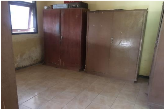
(Dokumentasi kondisi ruangan setelah dibersihkan)
