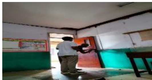
( Memperbaiki pintu perpustakaan yang rusak )
