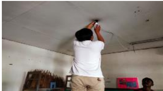
( Memasang lampu di perpustakaan )
